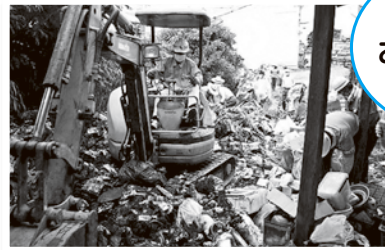
ごみ屋敷の片付け作業
